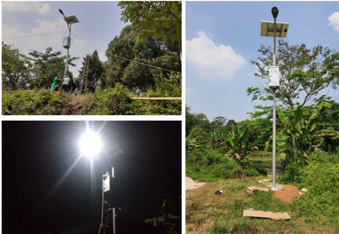
Gambar 6. Pemasangan PJU Solar Panel di dua titik
