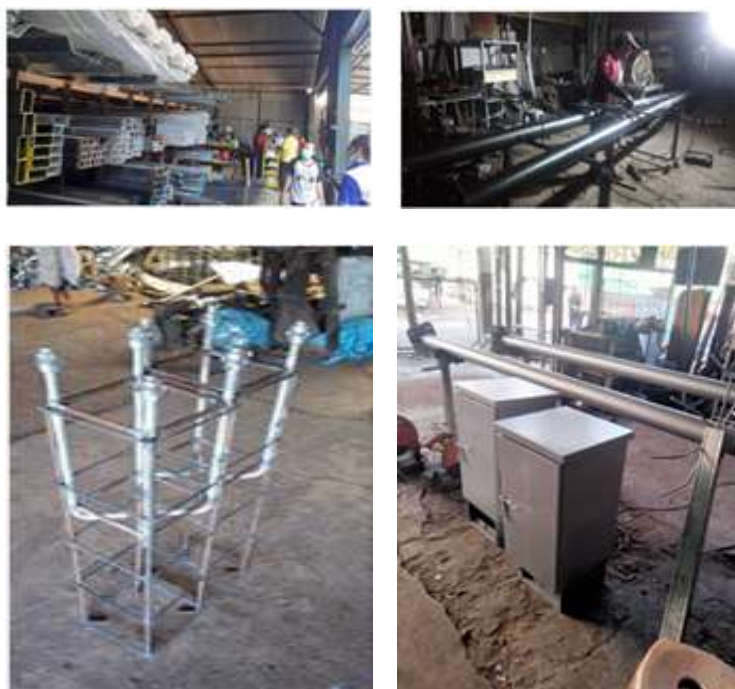
Gambar 5. Persiapan teknis pemasangan PJU Solar Panel
