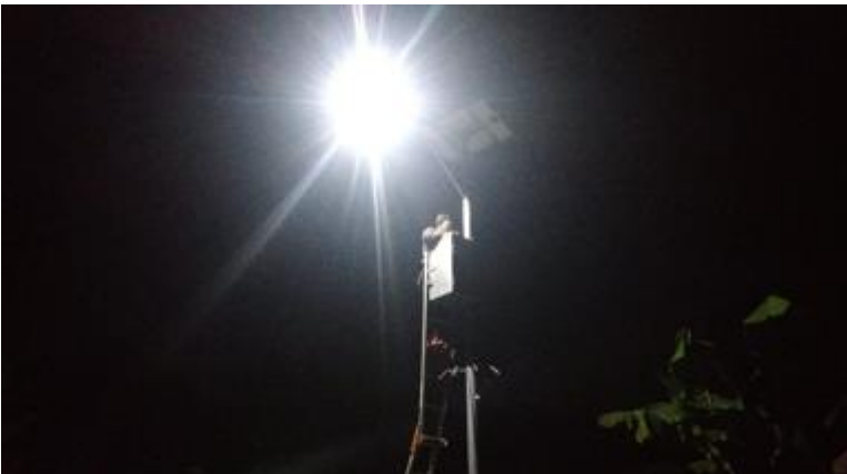
Keterangan gambar 4: Kondisi Lampu Penerangan Jalan Umum pada malam hari.
